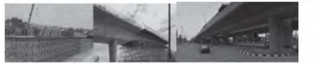
รูปที่ 5-14 โครงสร้างสะพานแบบคานรูปกล่องชนิดหล่อในที่ (Cast-in-Place Concrete Box Girder)
